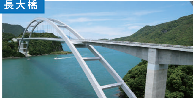
国道266号 天城橋 / 熊本県上天草市~宇城市
