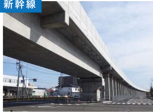
北陸新幹線 高柳高架橋 / 福井県福井市
