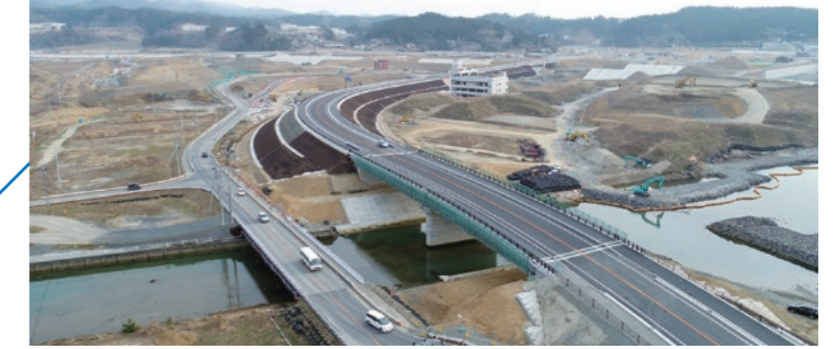
国道45号 水尻橋 / 宮城県本吉郡南三陸町
