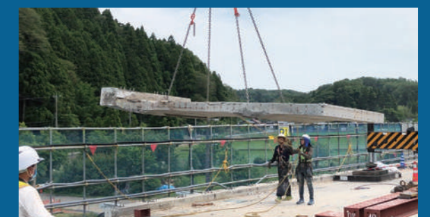
リニューアル工事
