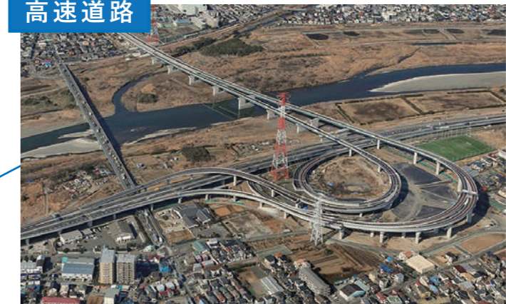
新東名高速道路 海老名南JCT / 神奈川県海老名市
