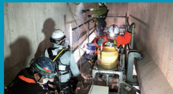
メンテナンス・補強工事
